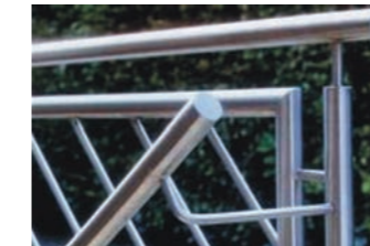
Detail eines Geländers
