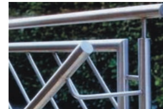
Detail eines Geländers
